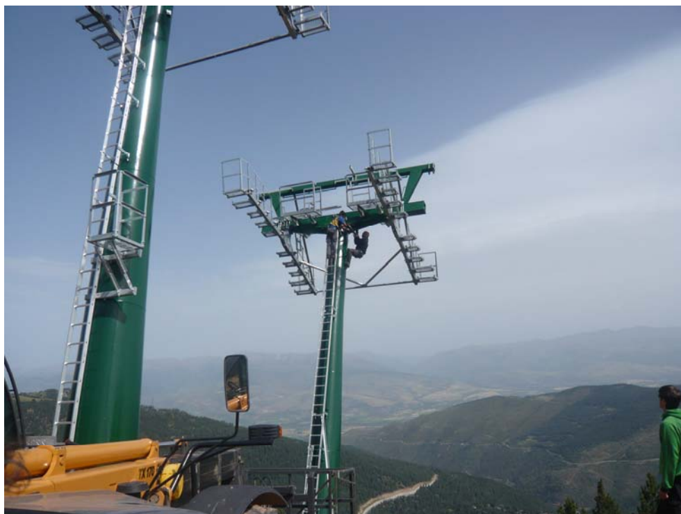
La nova instal·lació disposa de 13 pilones de línia
