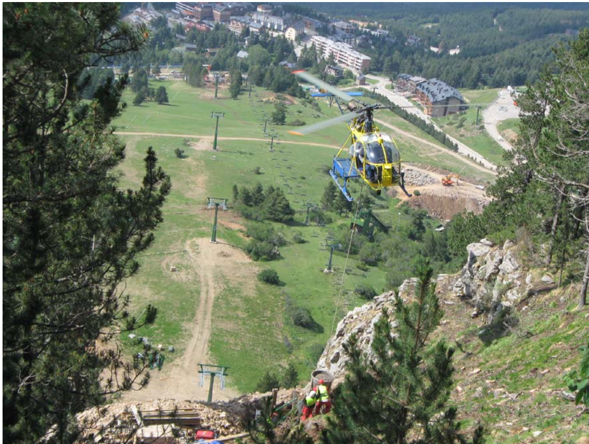
Treballs d'instal·lació de les pilones del nou Telecadira
