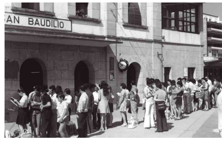
L'estació de Sant Boi de Llobregat durant els darrers anys de la dictadura franquista. Arxiu FGC (1975).
