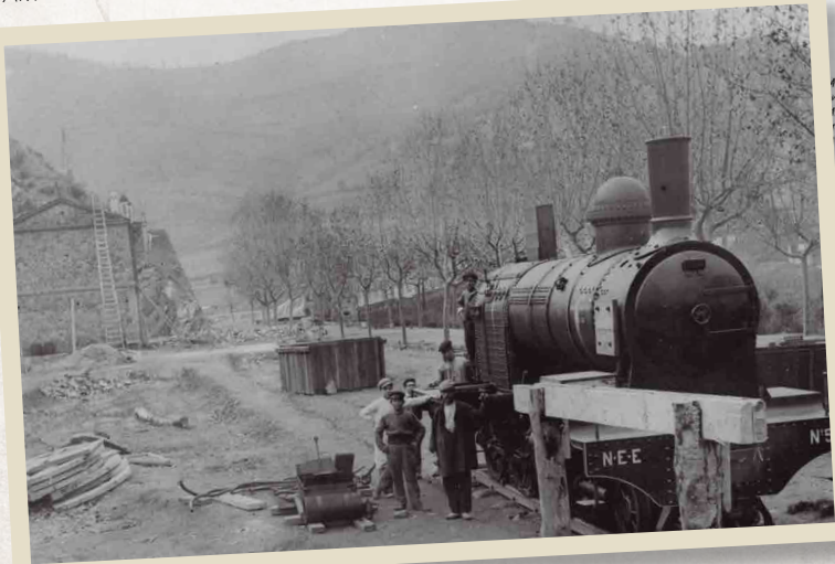
Construcció de l'estació de Martorell Vila. Arxiu Salmerón (1911).
