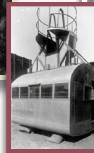
Construcció del telefèric de Sant Jeroni als Tallers Damians. Arxiu FGC (1929).
