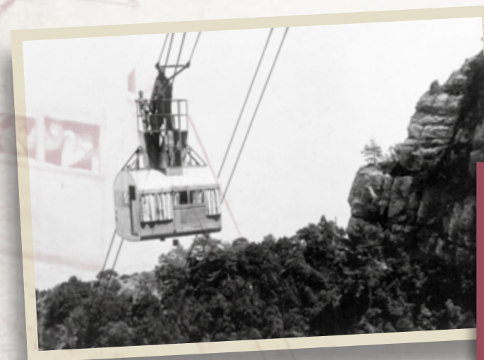
El telefèric funcionava per mitjà d'un sistema funicular impulsat des de l'estació superior. Arxiu FGC (1929).
