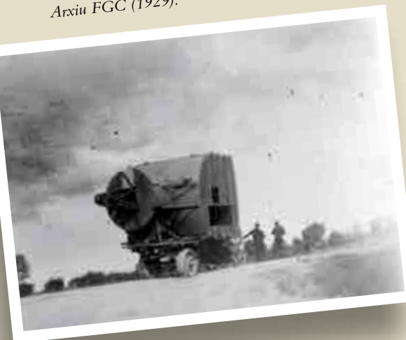
Trasllat de les cabines durant la construcció del telefèric. Arxiu FGC (1929).
