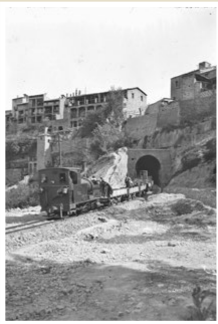
Construcción de la línea entre Sant Vicenç y Manresa, con una de las primitivas locomotoras Krauss del TFEMB realizando un tren de trabajo. Archivo Comarcal del Bages (c1920).
