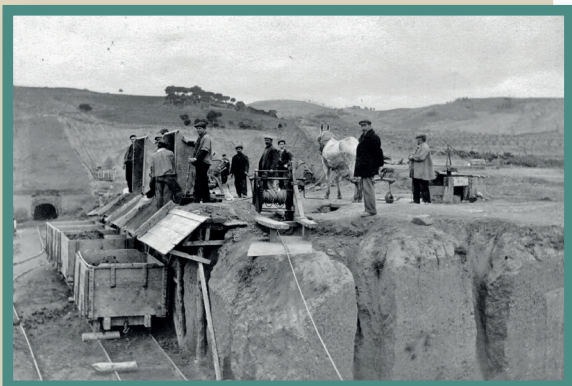
Obres de construcció de la línia entre Martorell i Olesa de Montserrat. Arxiu FGC (c1920).
