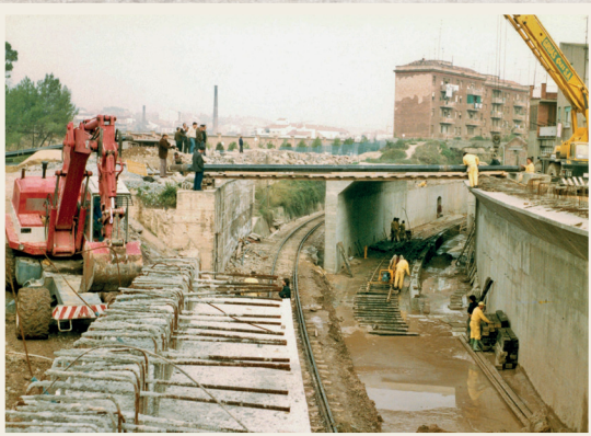
La modernització de les instal·lacions va incloure cobertures de vies i la construcció de noves estacions, com és el cas de Manresa i del barri de Viladordis. Arxiu FGC (1982).
