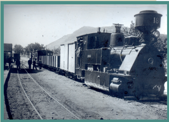
Un tren mixt del Tramvia o Ferrocarril Económico de Manresa a Berga a l'estació de Balsareny. Arxiu Salmerón (c1910).
