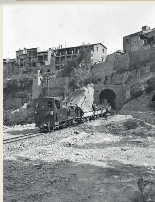
Construcció de la línia entre Sant Vicenç i Manresa, amb una de les primitives locomotores Krauss del TFEMB. Arxiu Comarcal del Bages (c1920).
