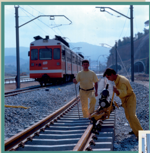
Els treballs de renovació de via van ser una de les primeres prioritats de la nova companyia ferroviària FGC. Arxiu FGC (c1992).
