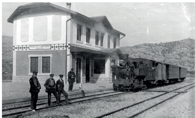
Tren de proves de la línia entre Martorell i Manresa, a l'estació d'enllaç amb el cremallera de Montserrat. Arxiu Salmerón (1922).
