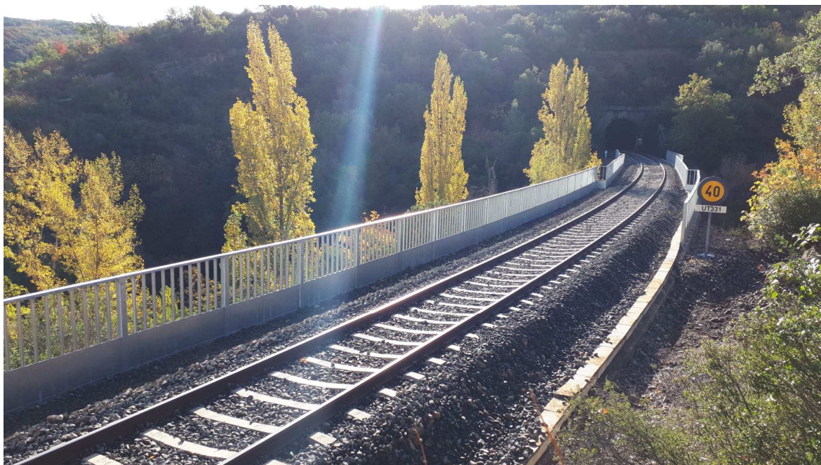
Noves baranes al pont del Barranc de Montclús.
