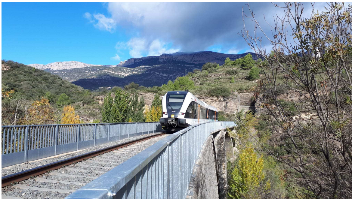
Noves baranes al pont del Riu Fred de Pui.
