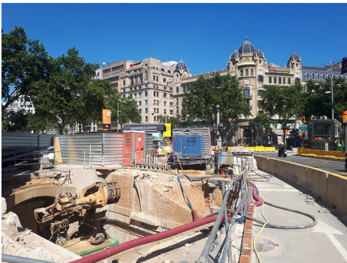
Estat actual de les obres.
