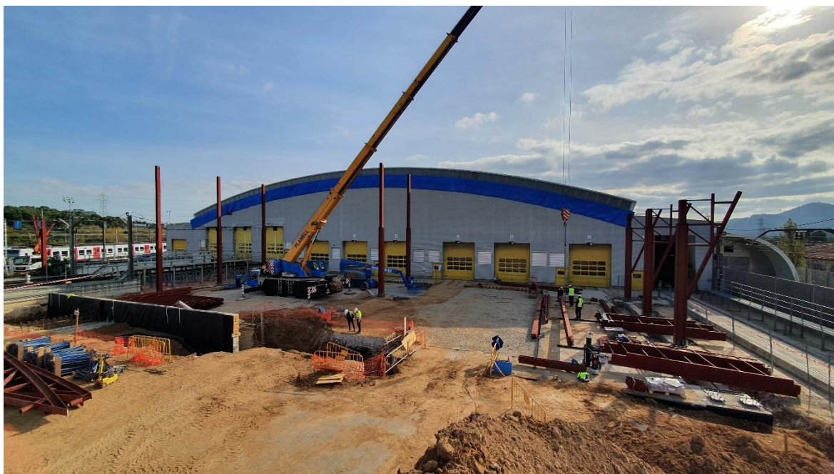
Les obres als tallers de Rubí.
