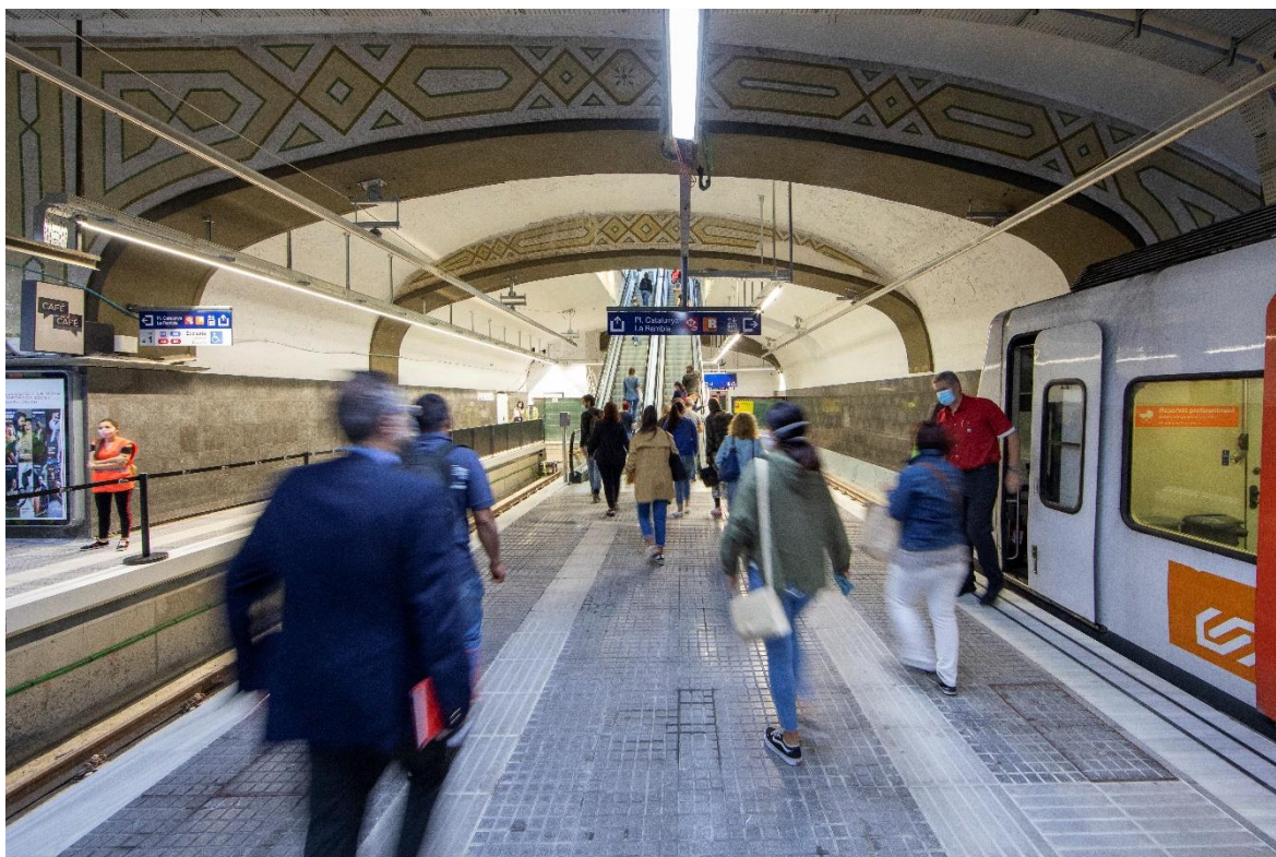
Amb les obres s'han allargat les andanes i vies 1, 2, 3 i 4.
