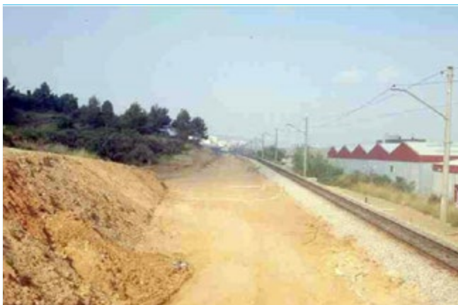
Plataforma preparada per a via doble.
