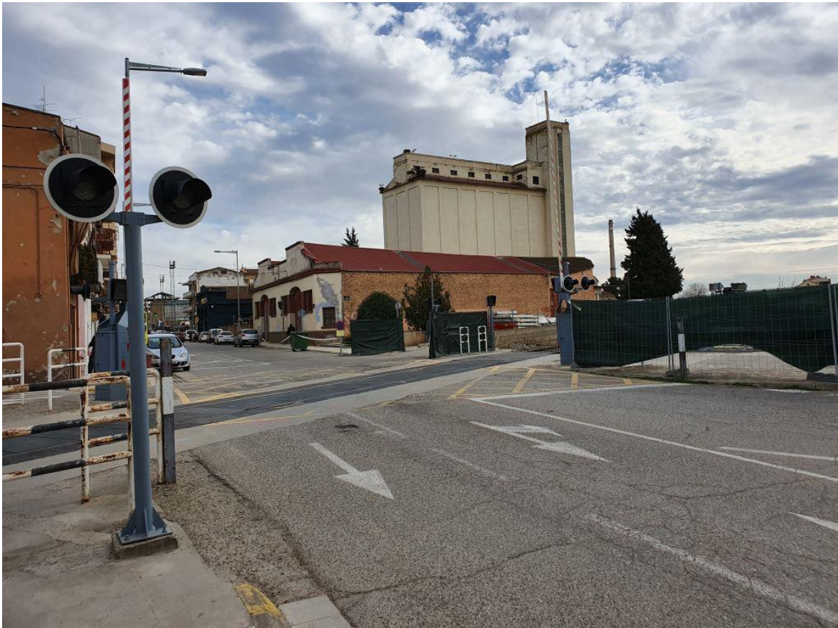
Foto del pas a nivell de Balaguer on es duran a terme les millores.
