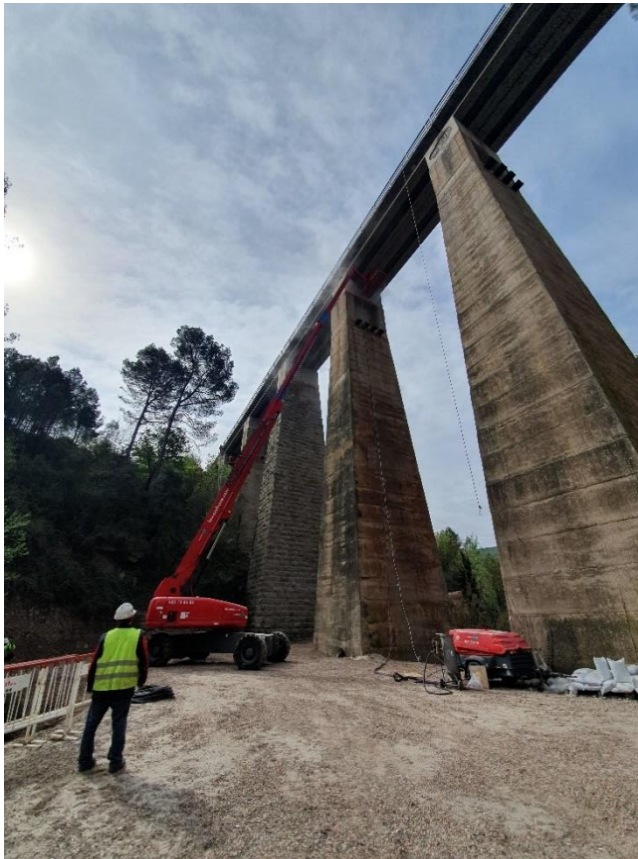
Obres al viaducte de Nenús.
