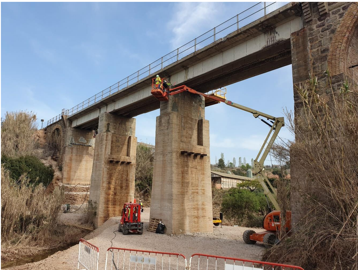
Obres al viaducte de Bellver.
