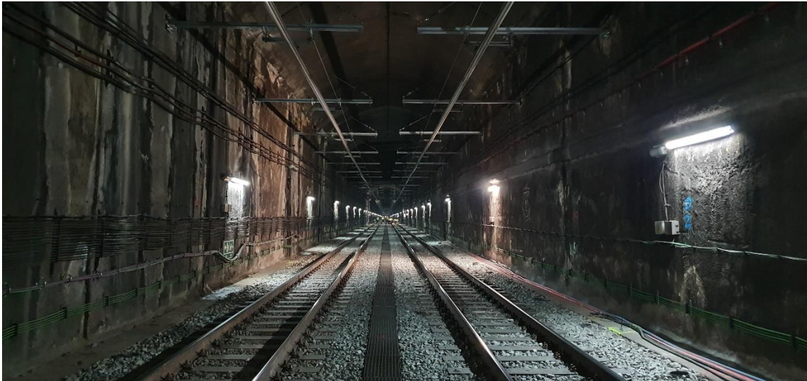
Imatge actual del tram de túnel entre Hospitalet i Almeda.
