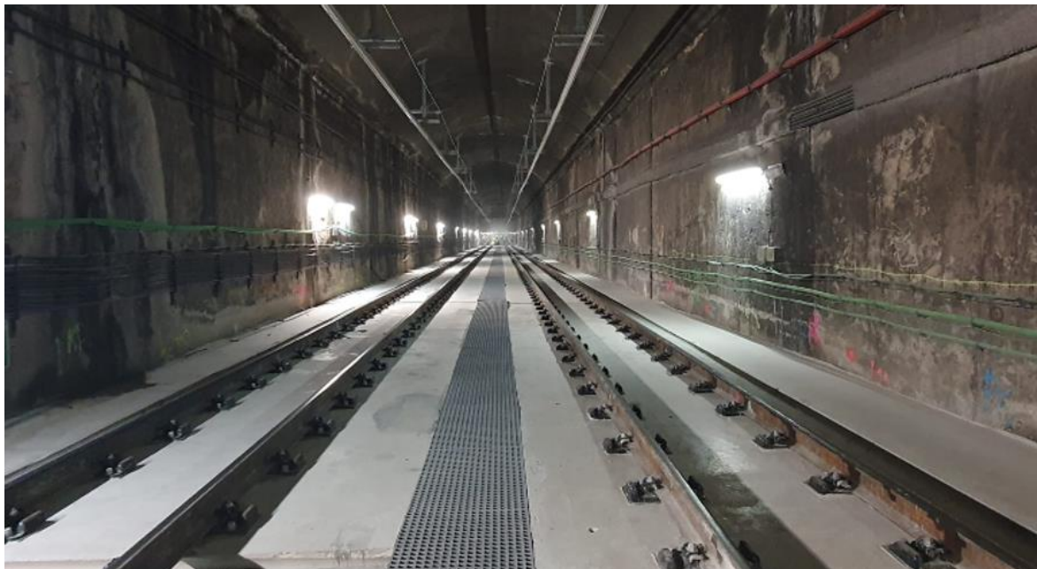
Imatge de l'actuació realitzada l'any passat entre les estacions d'Almeda i Cornellà Riera.
