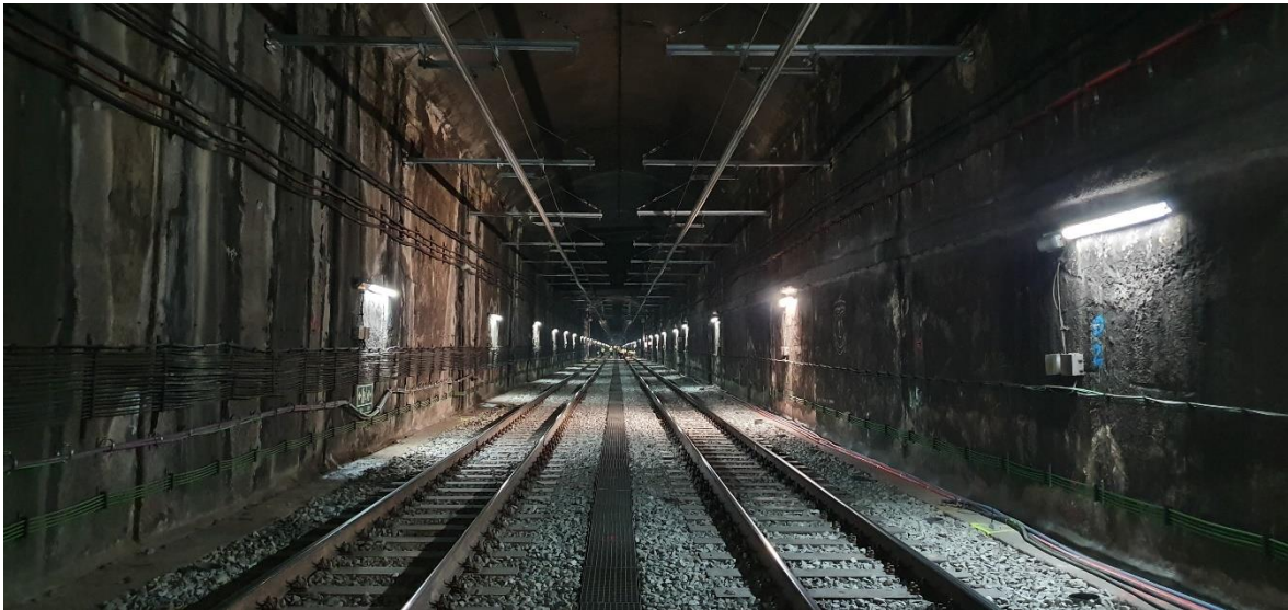
Imatge actual del tram de túnel entre Hospitalet i Almeda on es durà a terme l'actuació.
