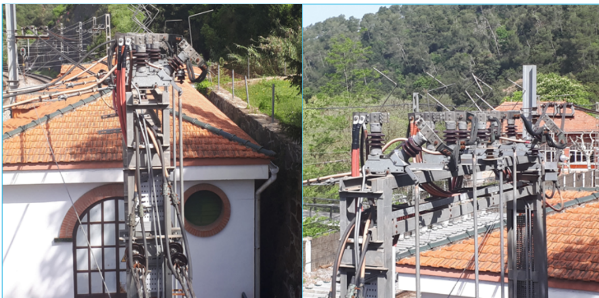
Feeders d'una catenària de la xarxa d'FGC.
