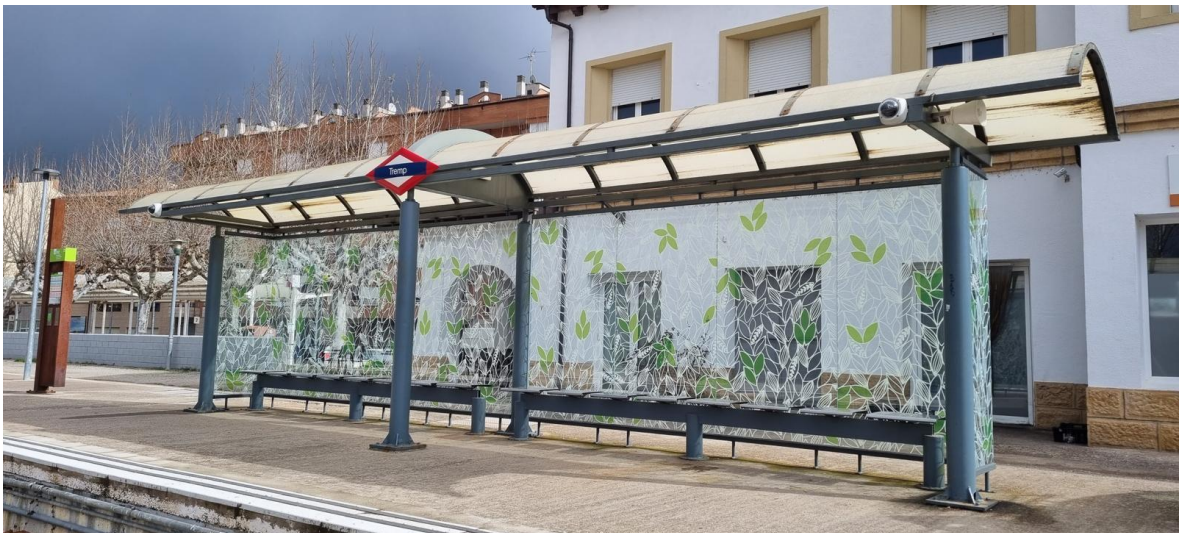
La marquesina instal·lada a l'estació de Tremp, amb el vinil per evitar el xoc d'aus.
