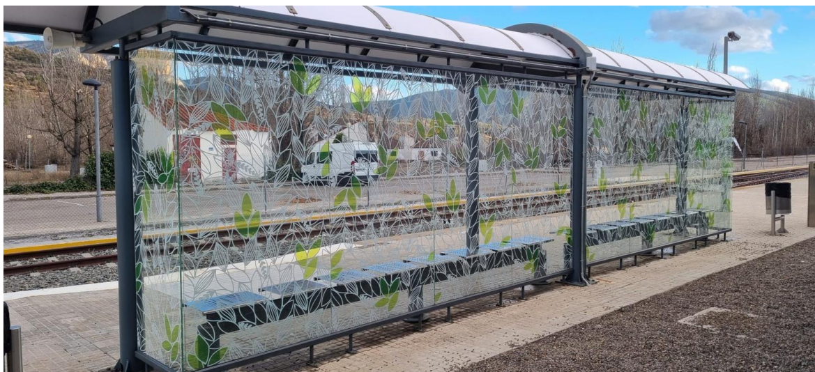
Imatge de la nova marquesina instal·lada a l'estació de La Pobla d'FGC.
